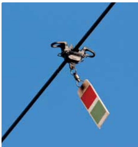
Flyer, az egyik legfontosabb (forgó) madárvédelmi berendezés. A vezetékkel ellentétben ezt észreveszik a madarak.
